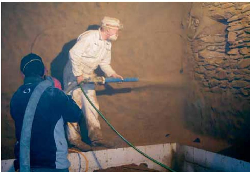
**Oben: Das Pflanzenkohle-Lehm-Gemisch wird in einem Druckstrahlverfahren auf die Trockensteinmauer aufgetragen. Auf diese Weise lassen sich in einem Arbeitsgang 10 bis 15 cm dicke Putzschichten für besseres Raumklima auftragen.**
